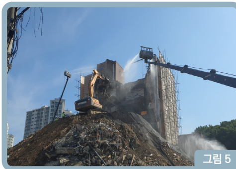
[그림 5] 성토체 및 살수작업 모습 [그림 6] 지하층 바닥 슬래브 보 붕괴모습
