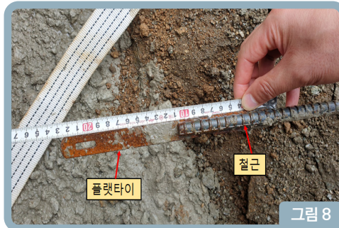
[그림 8] 임의제작한 거푸집긴결재 [그림 9] 거푸집긴결재(폼타이) 종류
