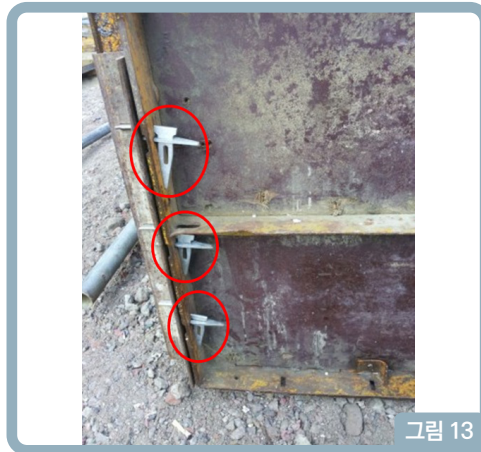
[그림 14] 유로폼 후크 및 웨지 핀 정상 체결 상태(타현장 사례)
